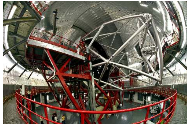
Figura 9: Estructura del telescopio. Fuente: H. Raab.
