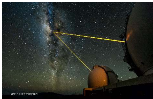
Figura 2: Vista nocturna de los Keck, usando láseres para proyectar una estrella virtual en el cielo y de ese modo, corregir los efectos de las turbulencias atmosféricas mediante óptica adaptativa. Fuente: Keck.
